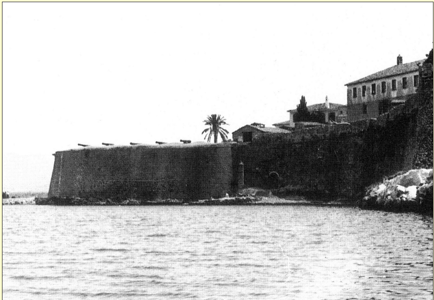
Εικ. 6: Γενική άποψη Πέντε Αδέρφια με τα παλαιά κανόνια από τα ΝΔ (φωτ. Σουηδικού Αρχαιολογικού Ινστιτούτου, 1920).
