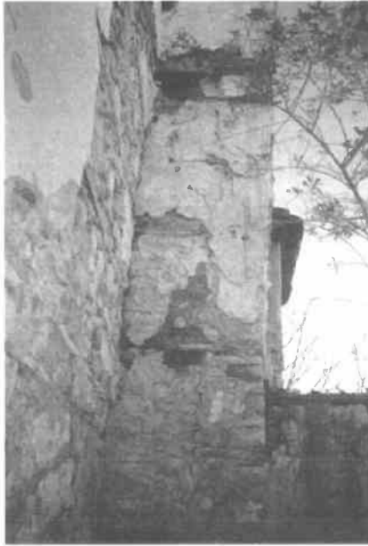
Εικ. 18. Φθορές στην τοιχοποιία.
