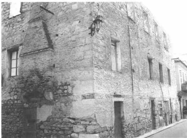
Εικόνα 1: Ενετικό κτίριο, μερική άποψη από Ν. Δ.
