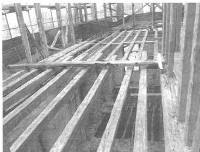
Εικ. 8. Ξύλινα δοκάρια μεσοπατωμάτων.
