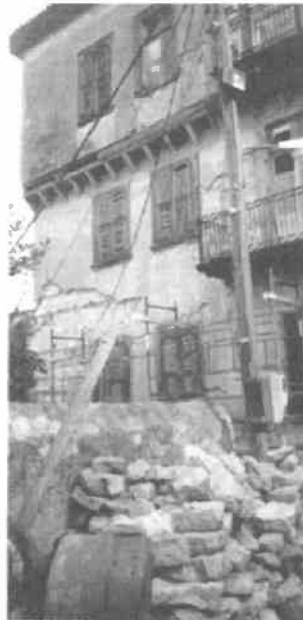
Εικ. 1-3. Γενικές απόψεις του κτιρίου στην πρότερη του κατάσταση. Προβάλλει επιβλητικό ανάμεσα στα γειτονικά κτίρια..
