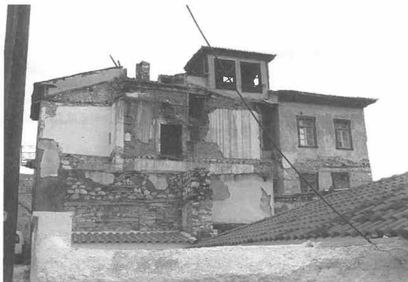
Εικ. 7. Πίσω όψη, απόληξη κλιμακοστασίου.
