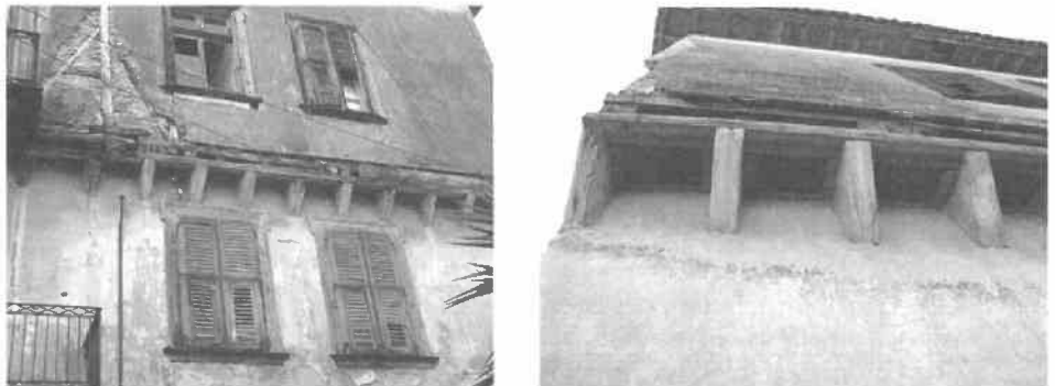
Εικ. 16-17. Σαχνισί που στηρίζεται σε ξύλινες αντηρίδες.
