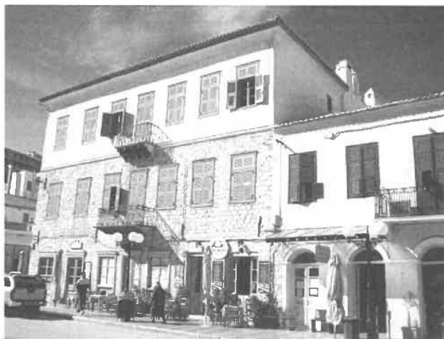
Εικ. 1. Γενική άποψη του κτιρίου από την οδό Συγγρού.
