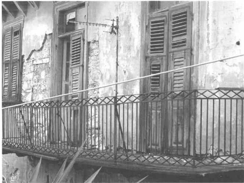
Εικ. 18. Φθορές στην τοιχοποιία.
