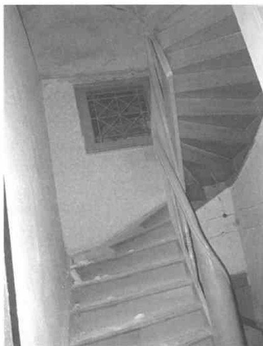
Εικ. 13. Κύριο Κλιμακοστάσιο.
